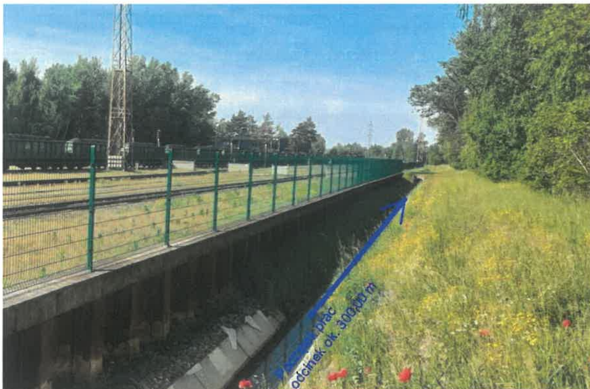
Rys. 2 Początek planowanych prac – rów opaskowy
