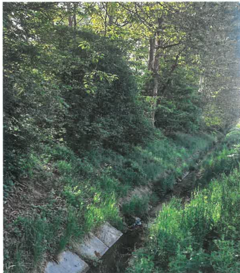
Rys. 2.1, 2.2 Początek planowanych prac – rów opaskowy Składowiska Pióry 6.4. Dostarczenie świadectw jakości dla zastosowanych materiałów, przed ich wbudowaniem.
